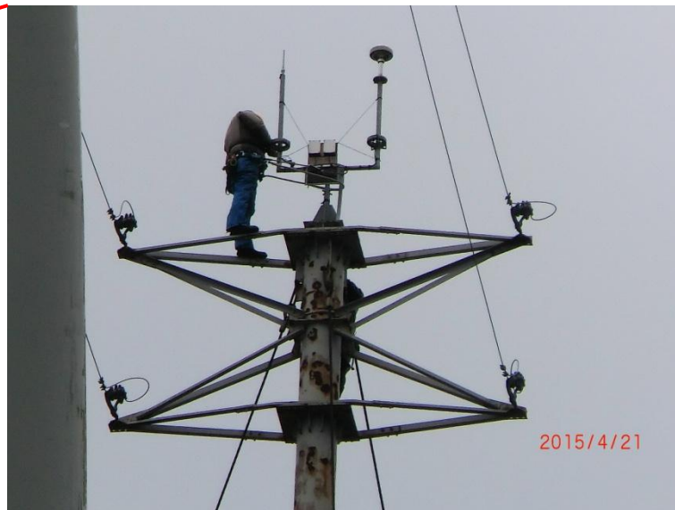
鉄塔の上での作業の様子
