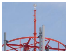
無線鉄塔への取付事例
