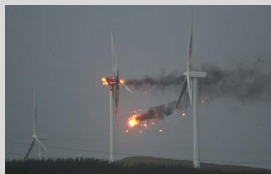
写真（2枚とも） 落雷による風車の火災
